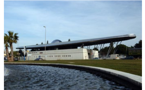
Médiathèque Garcia Lorca à Montpellier
