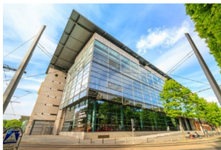
Médiathèque Emile Zola à Montpellier
